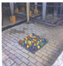
Le sfere colorate attivano il motion del sistema video in caso di fuoriuscita liquidi
